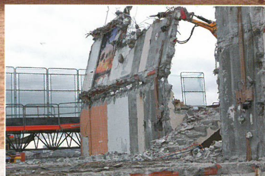
Démolition Savoir-faire diversifiés
