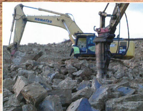
Carrière Holcim en Lorraine
