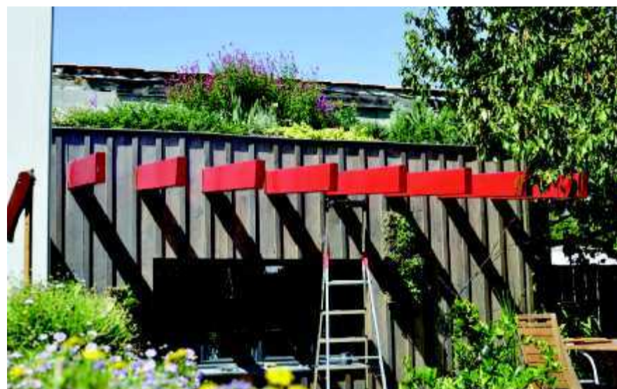
L'Atelier du Végétal crée des toitures naturelles et recyclées. PHOTO L'ATELIER DU VÉGÉTAL
